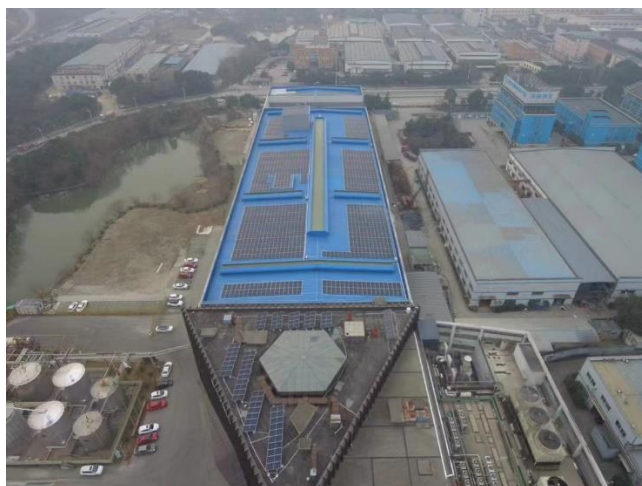
图.公司铺设光伏板图
